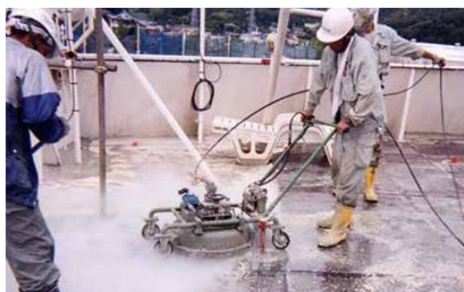
Очистка палубы судна напольным модулем, макс. давление 250МПа, подача 30 л/мин.
