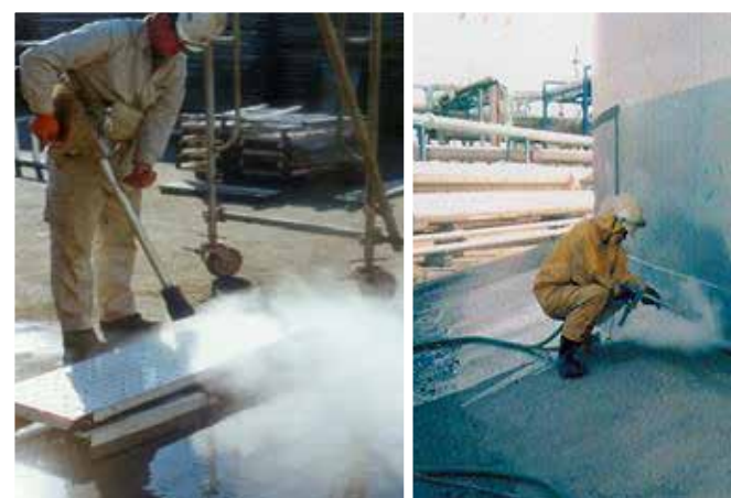
Очистка платформ, подмостей, макс. давление 150МПа.
